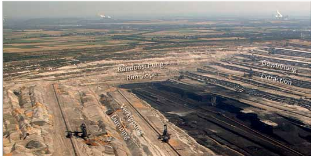
Fig. 2: Mine-rim slope system, Hambach mine Abb. 2: Randböschungssystem Tagebau Hambach
