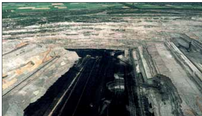
Fig. 3: Mine-rim slope system supported between digging and dumping slopes, Hambach mine Abb. 3: Zwischen Gewinnungs- und Verkipfungsböschungen eingespanntes Randböschungssystem im Tagebau Hambach
