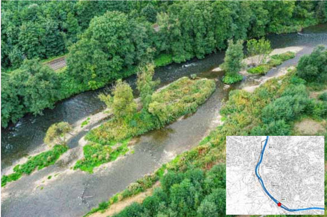
Abb. 3-13: Luftbild aus dem Bereich Binnerfeld BA I im Jahr 2013 (Bereich unterhalb des Café R, in Fließrichtung gesehen)
