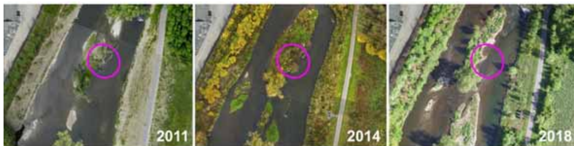
Abb. 2-33: Bauabschnitt III: Einbau eines Totholzstammes nahe einer Kiesinsel in der Mitte des Flusslaufes – Darstellung der Entwicklung im Umfeld in den Jahren 2011, 2014 und 2018
