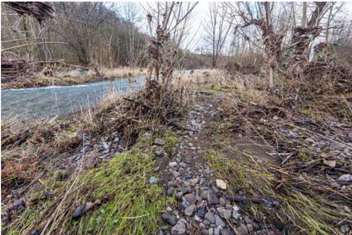
Abb. 3-36: Auftrag bzw. Freispülen von Kiesen und Schottern im Bereich von Hochstauden und jungen Gehölzen
