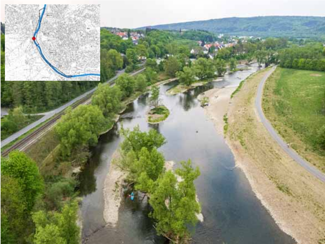
Abb. 3-11: Bauabschnitt III im Jahr 2011 (Schrägluftbild; flussabwärts)
