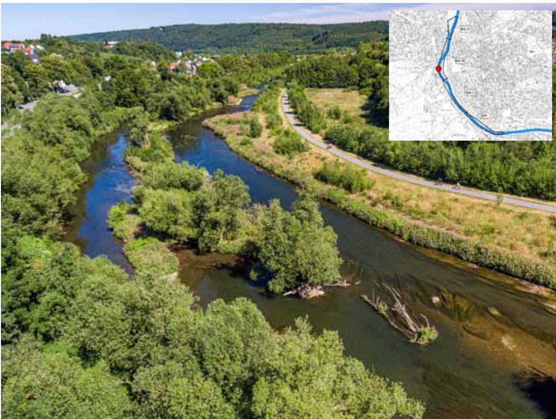
Abb. 3-12: Bauabschnitt III im Jahr 2016 (Schrägluftbild; flussabwärts)
