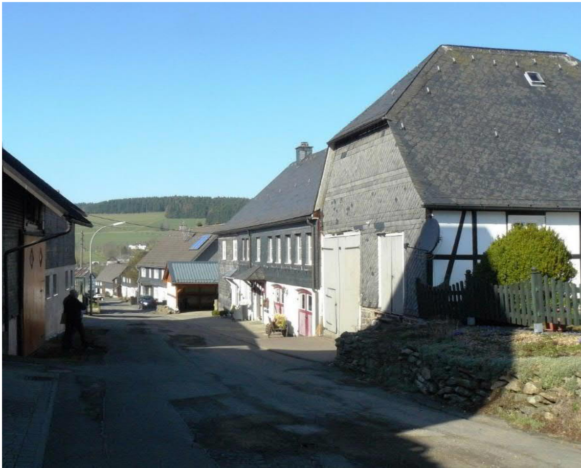
Abbildung 10: Grobelweg, Zustand der Straßenoberfläche und Hausvorfläche von Haus-Nr. 4
