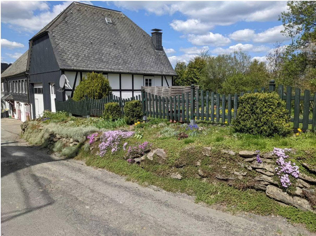
Abbildung 22: Vorhandene Bruchsteinmauer entlang des Hausgrundstückes 4 im Grobelweg
