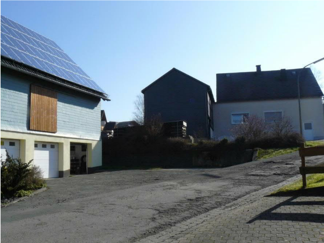
Abbildung 7: Bornlochweg, Zustand der Straßenoberfläche und Hausvorfläche von Haus-Nr. 2
