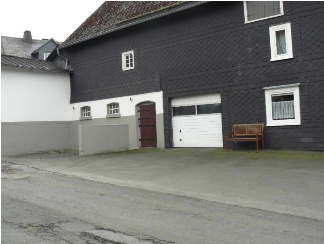
Abbildung 21: ehem. landwirtschaftliches Gebäude (Grobeweg 1) mit abgemauerter Jauchegrube
