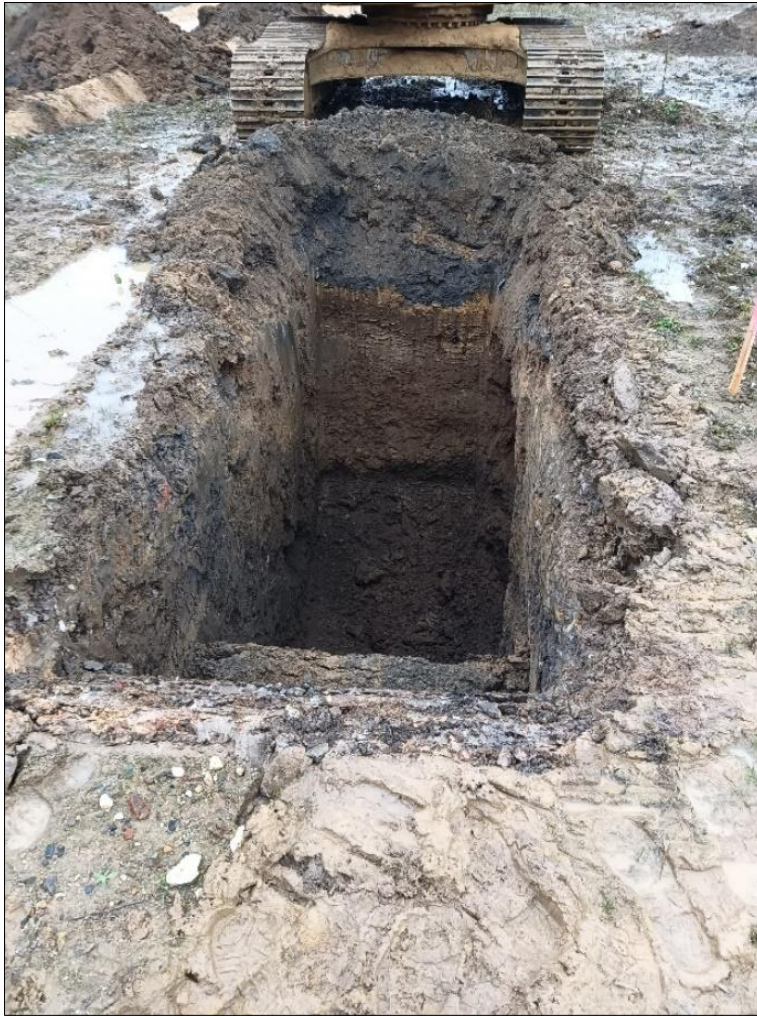
Abb. 10: Schurf 1 „Pösenberg“ mit typischen, schichtartigen Farb- und möglicherweise Materialwechseln innerhalb eines Schüttkörpers
