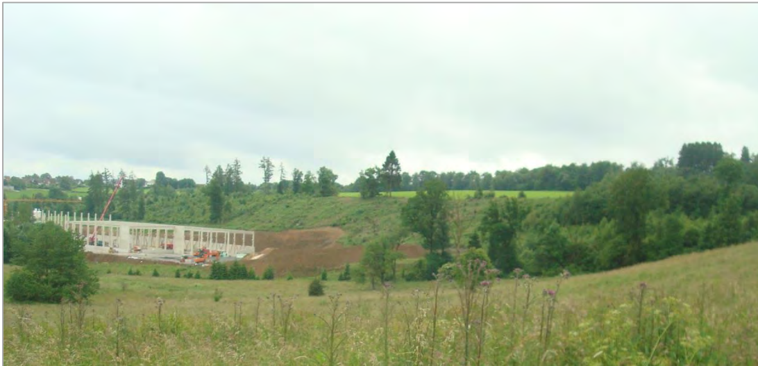
Abb. 18: Foto der GIB-Erweiterungsfläche aus nördlicher Richtung – Blickrichtung: Süden
