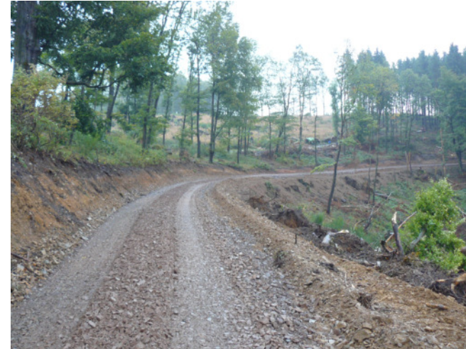
Neubau Holzabfuhrweg in der Bauphase (Attendorf)
