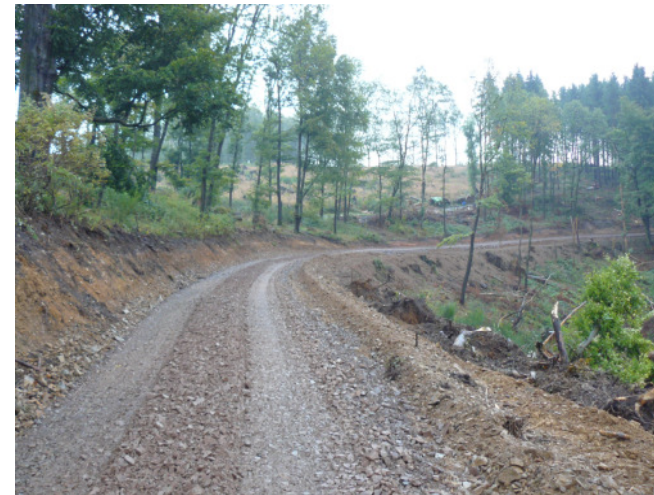
Neubau Holzabfuhrweg in der Bauphase (Attendorf)
