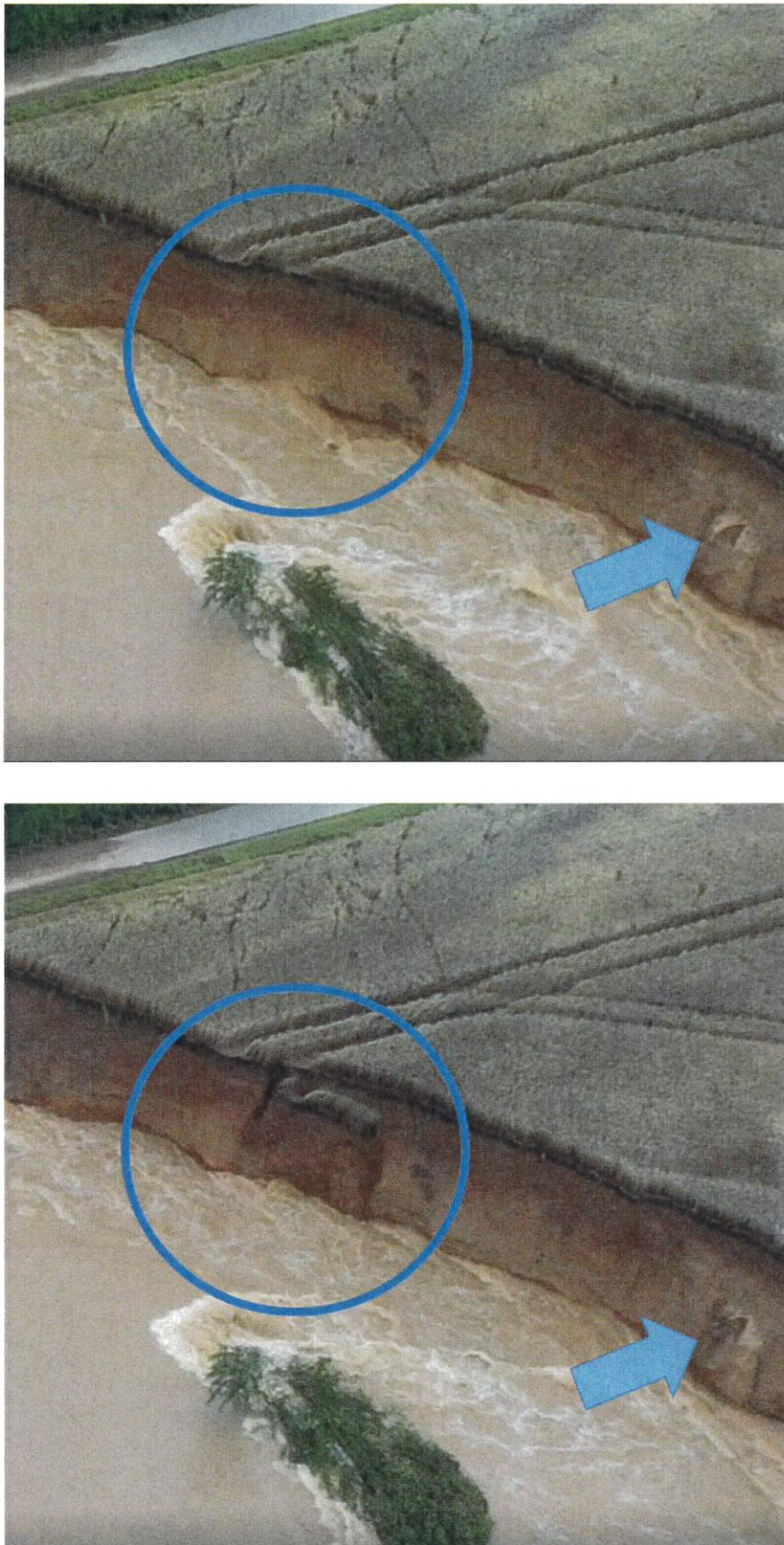
Abb. 20: Schalenartiger Verbruch und Piping-Effekt
