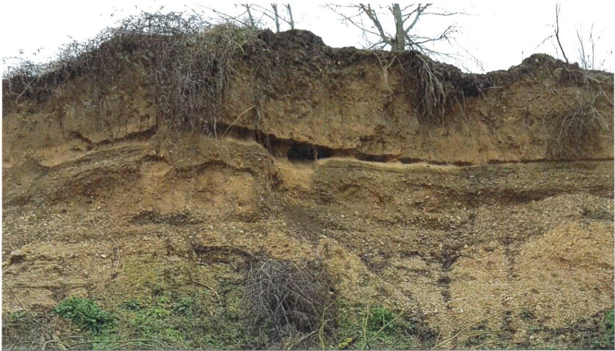
Abb. 16: Hochflutsandschicht in der Südwestböschung
