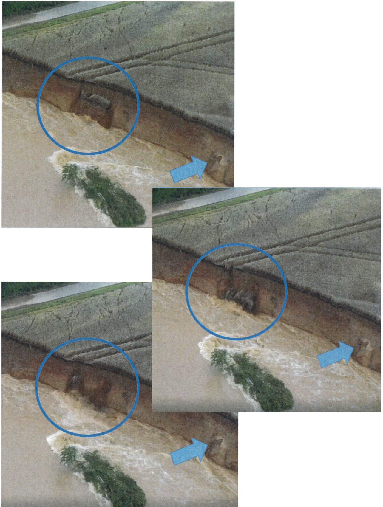
Abb. 21: Schalenartiger Verbruch und Piping-Effekt
