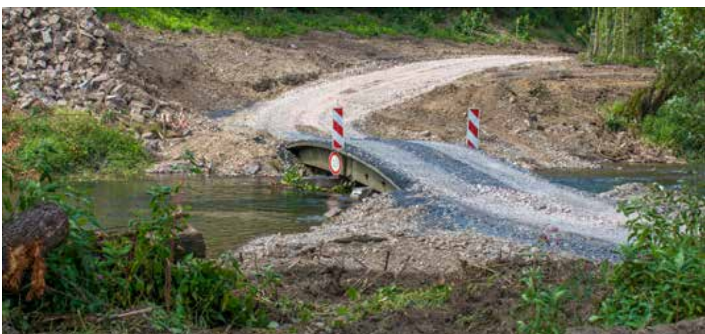
Bauzeitliche Behelfsbrücke: Die Maßnahmenumsetzung erforderte eine sorgfältig geplante Bodenlogistik. Lehmige Böden wurden abgefahren. Kiese und Schotter wurden zur Sohlanhebung wieder in den Flusslauf eingebaut.
