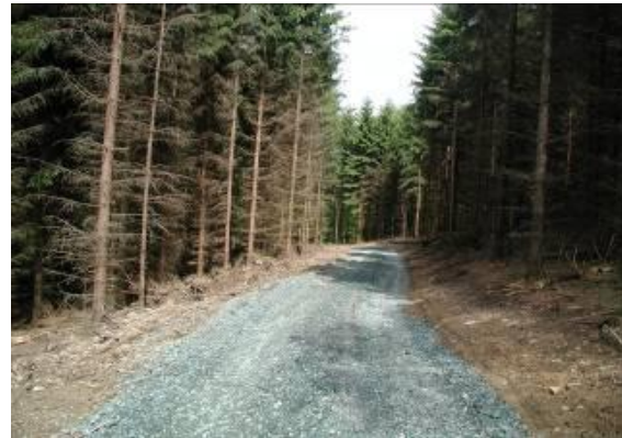
Neubau Holzabfuhrweg (in der Bauphase)
