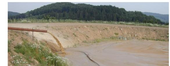
Abb. 6: Sedimentationsbecken
