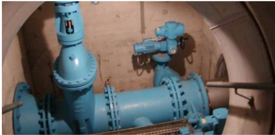
Abb. 7: Entnahmeeinrichtungen (Grundablassschieber)
