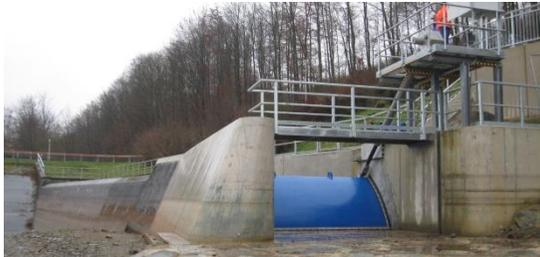
Abb. 8: Hochwasserentlastungsanlage
