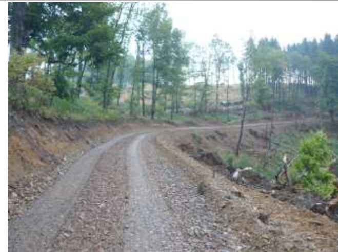
Neubau Holzabfuhrweg in der Bauphase (Attendorf)
