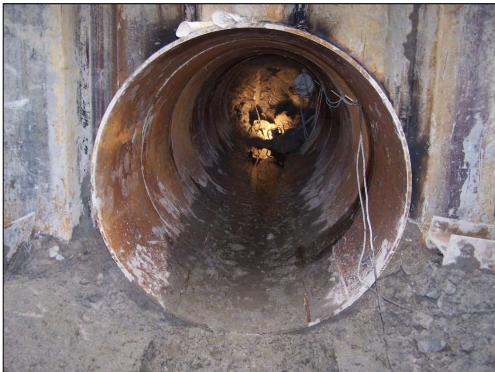
Abbildung 8: Schachtvortrieb
