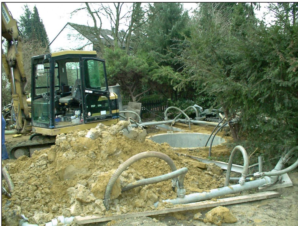
Abbildung 6: Schachtringverbau mit Wasserhaltung
