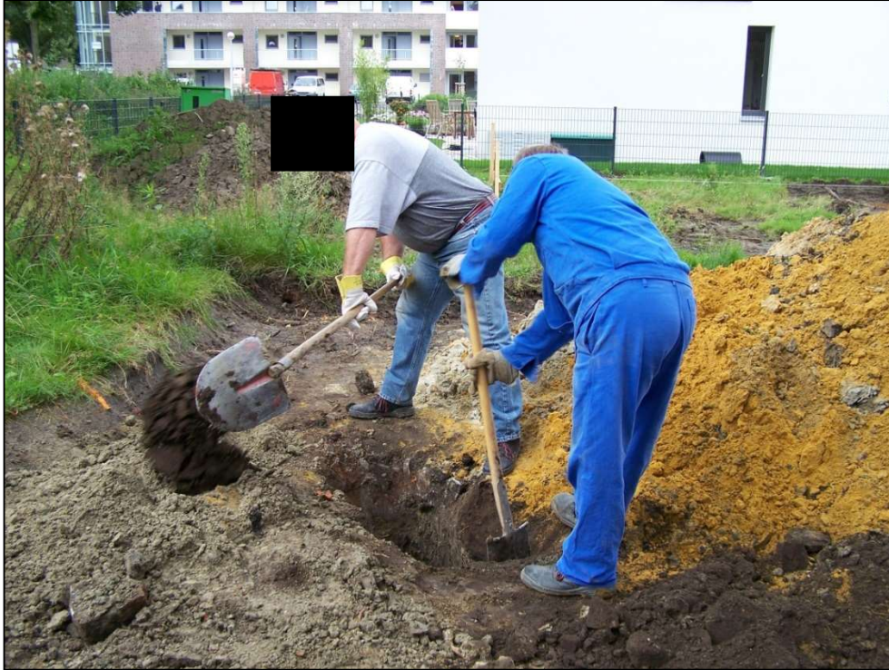
Abbildung 9: händischer feststellender Bodeneingriff
