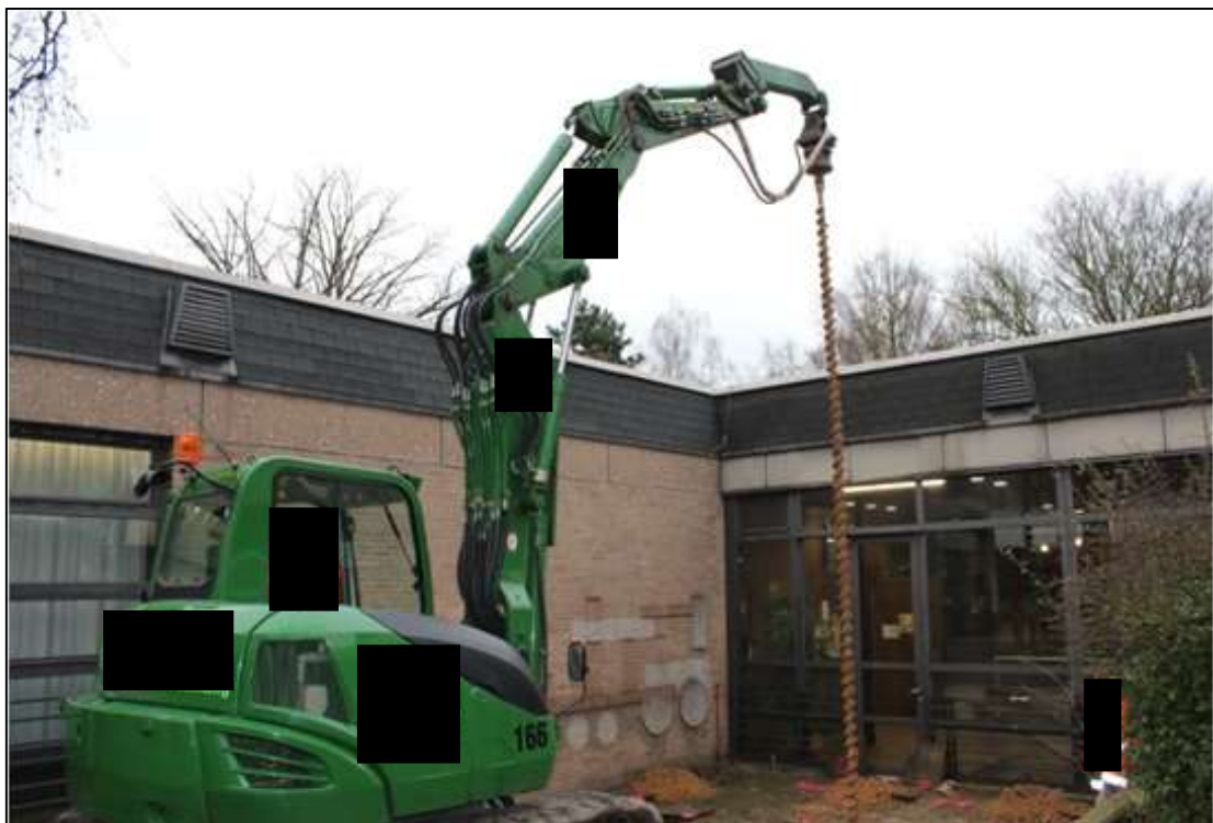
Abbildung 4: Schneckenbohrung Ø 150 mm
