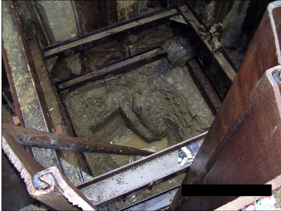
Abbildung 7: Spundwandverbau
