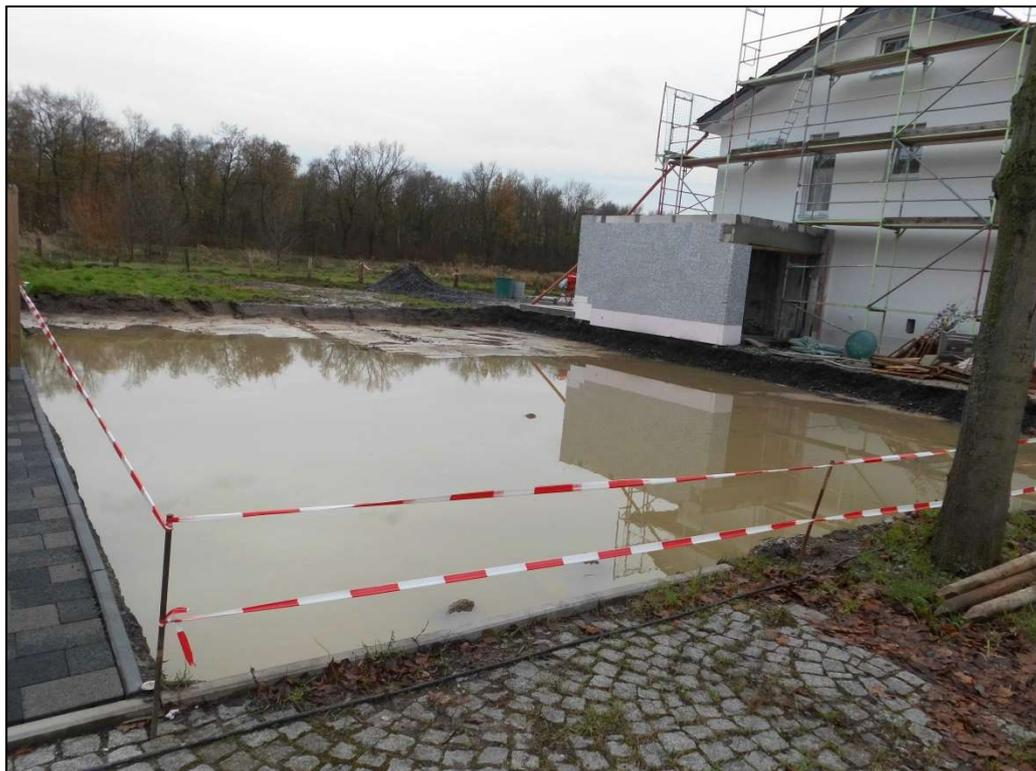
Abbildung 4: Hoher Wasserstand in Baugrube
