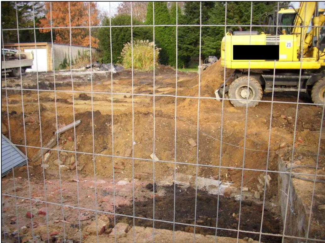
Abbildung 5: Bauschutt / Auffüllungen in der Sondierfläche
