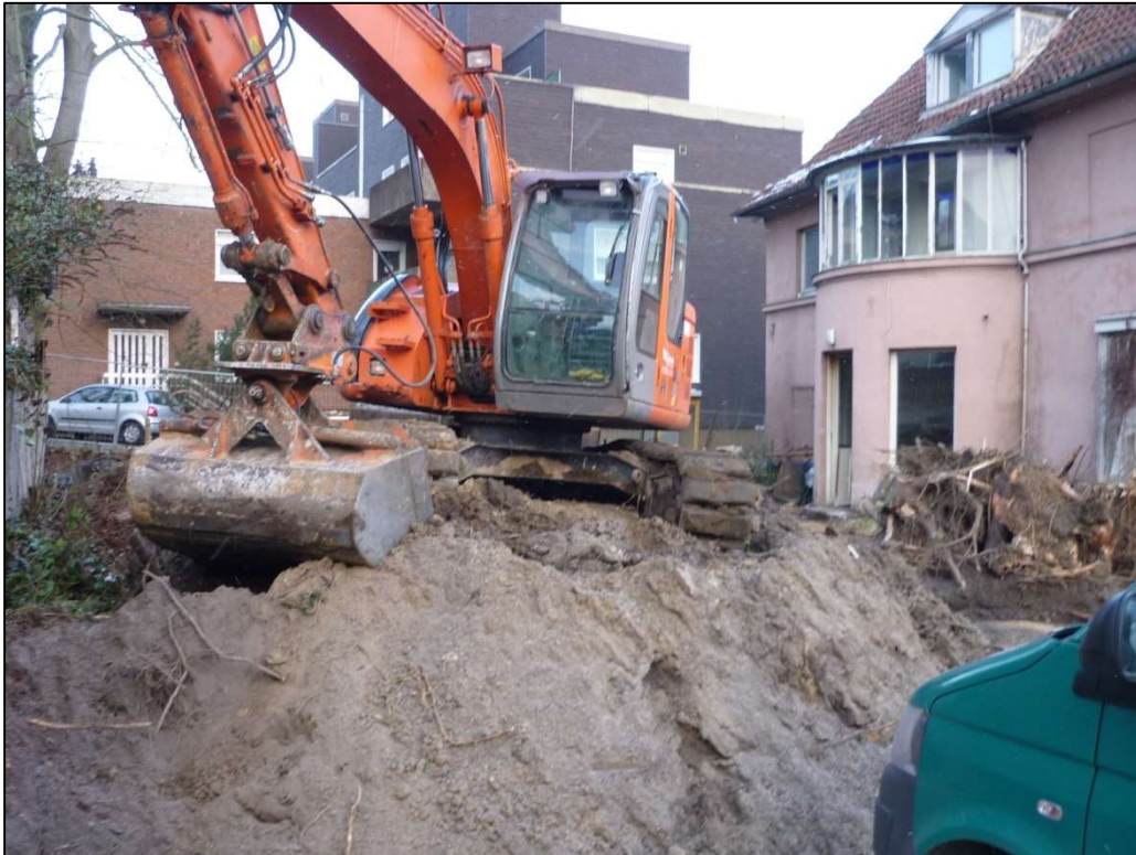
Abbildung 9: Material, Unwegsamkeiten, Baugeräte in der Sondierfläche
