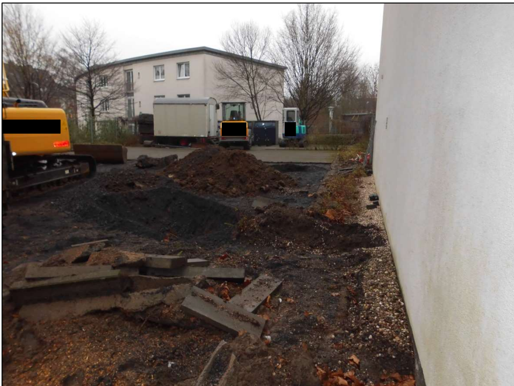
Abbildung 8: Bauschutt, Unwegsamkeiten, Baugeräte in der Sondierfläche
