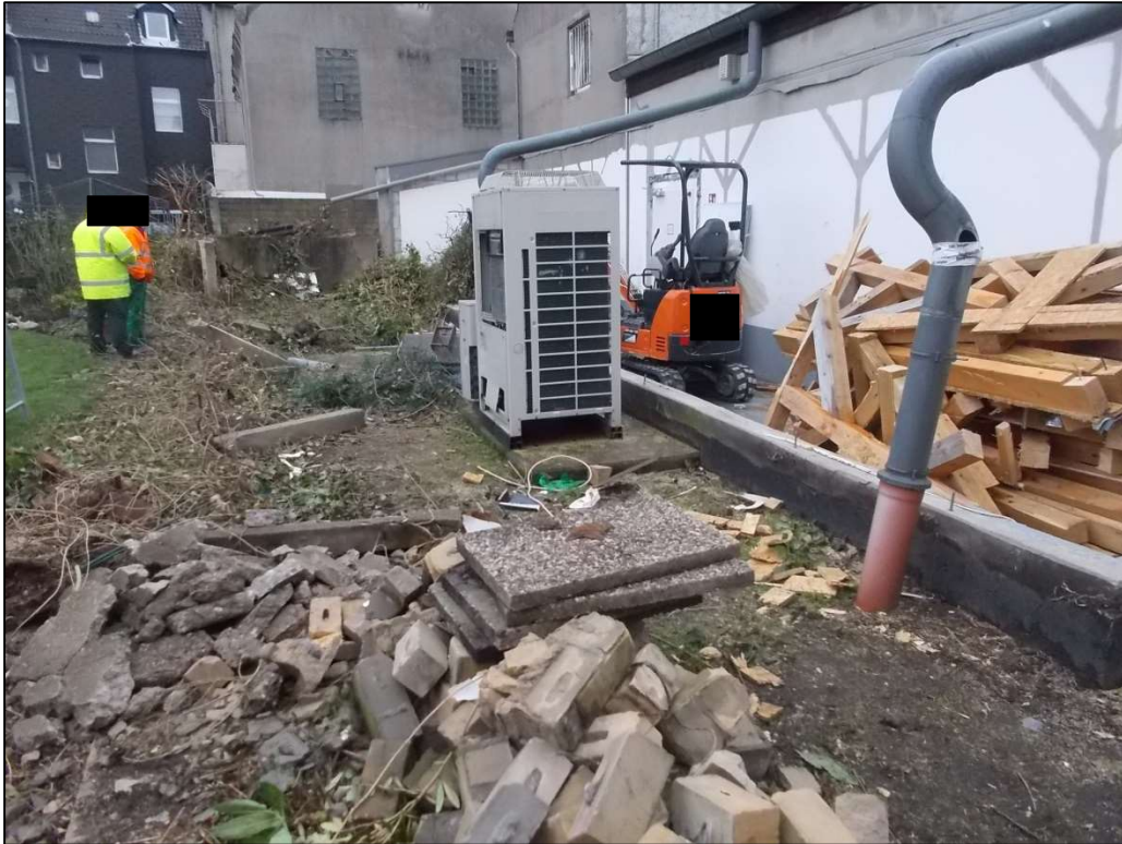
Abbildung 7: Bauschutt, Unwegsamkeiten, Baugeräte / Geräte in der Sondierfläche
