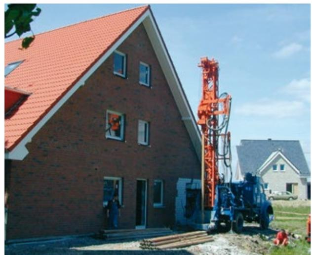
**Bild 1.2** – Geothermiebohrung
