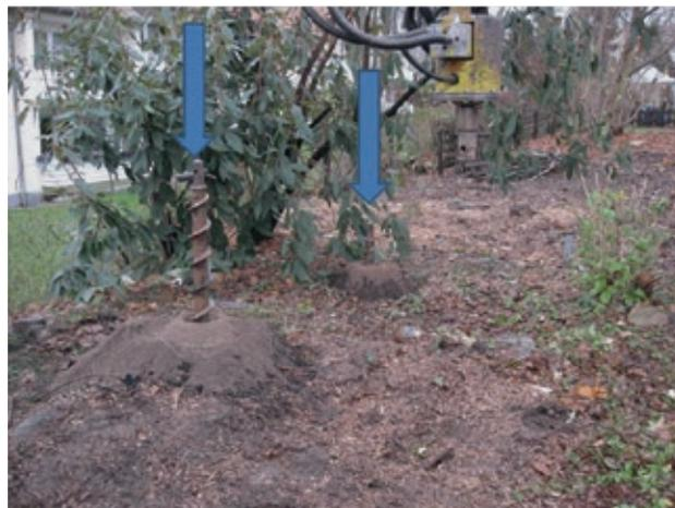
**Bild 12.4**– Gestänge zur Herstellung von zwei Kampfmittelsuchbohrungen
