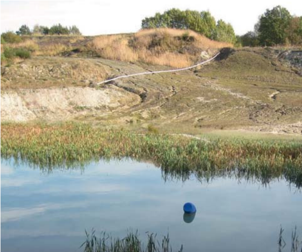
Bild 3.7 – Entwässerung des Tagebaues
