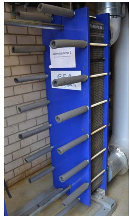
**Bilder 4.1 und 4.2** – Pumpenwerkstatt und Plattenwärmetauscher, RWE Power AG, Elsdorf
