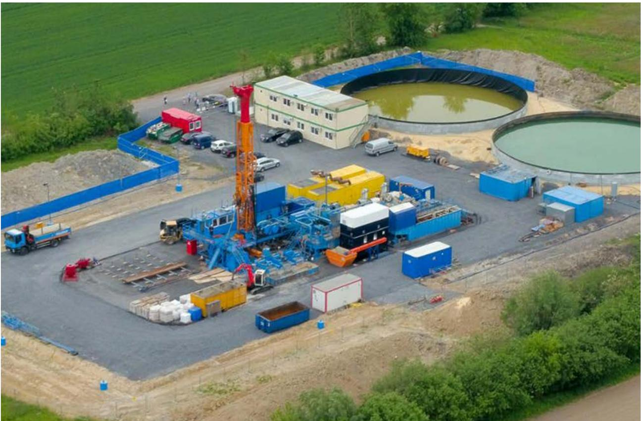
**Bild 8.4** – Bohranlage DS 05 – Fa. Daldrup & Söhne AG aus Ascheberg – im Mai 2016 auf der Bohrlokation „Herbern 58“ mit den zwei Speicherbecken für jeweils ca. 1.500 m<sup>3</sup> Brauchwasser (Quelle: HammGas)
