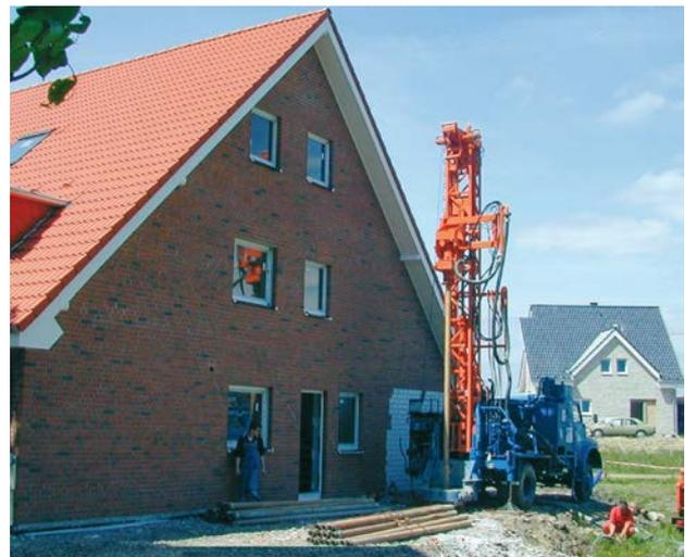
**Bild 1.2** – Geothermiebohrung
