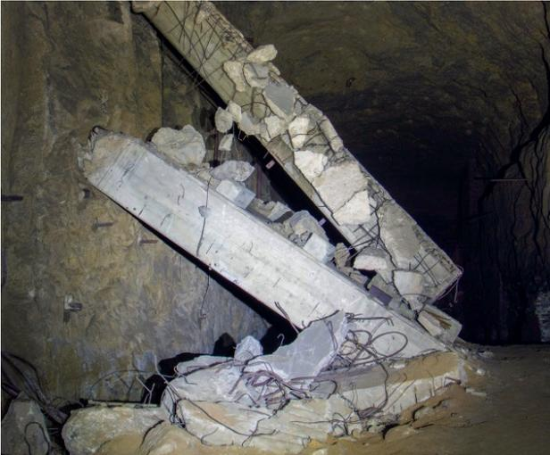
**Bild 12.5** – Gesprengte Stahlbetondecke
