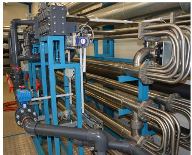
**Bilder 4.4 und 4.5** – Wärmepumpen und Röhrenwärmetauscher, Erftverband, Bergheim
