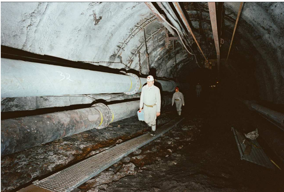
Abb. 18: Röhrensystem, Hauptwasserweg im BW Haus Aden/Monopol (Foto: RAG)
