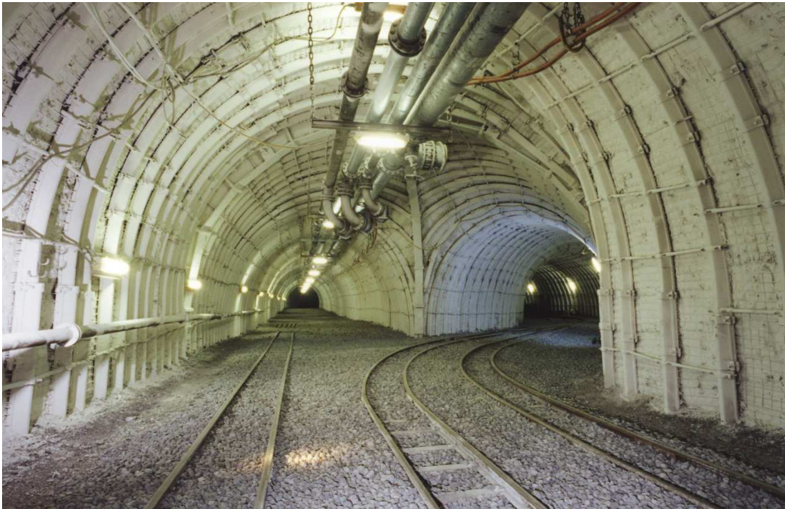
Abb. 17: Röhrensystem, geschotterter Hauptwasserweg im BW Auguste Victoria (Foto: RAG)
