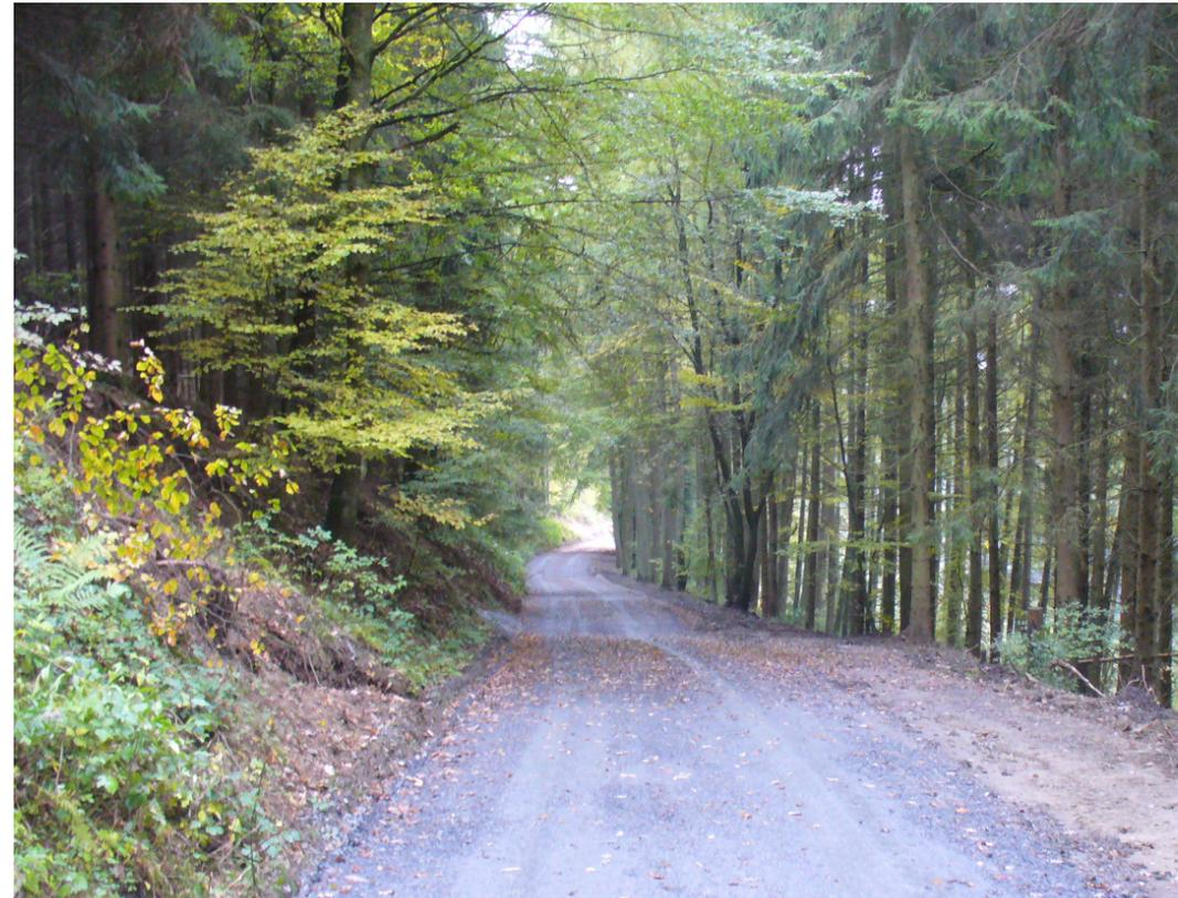
Ausbau im Steilhang mit Engstelle zur Schonung der beidseitigen Bestände; weitgehende Erhaltung Kronenschluss wegen Fledermäusen und Windwurf
