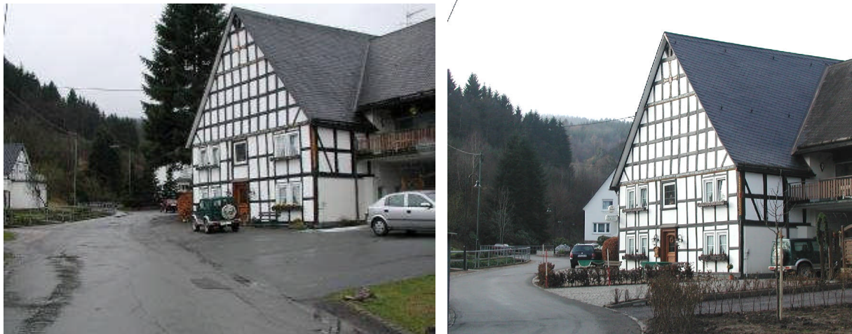
Abb.: Ausschnitt der Straße „Im Inken“ vor und unmittelbar nach dem Ausbau
