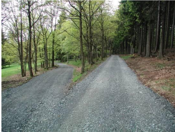
Photo (links) : Ausbau von Holzabfuhrwegen Photo (rechts) : Bau einer Furt
