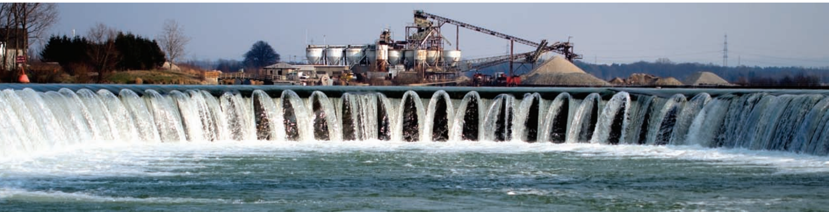
Auslaufbauwerk des Lippesees - eine unüberwindbare Barriere
