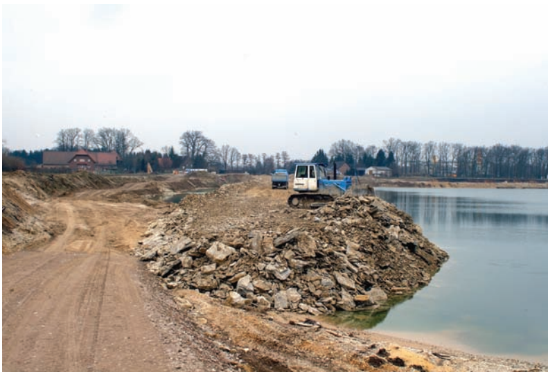
Hochwasserentlastungsdamm während der Vorschüttung und mit fast fertiger Abdeckung (rechts)
