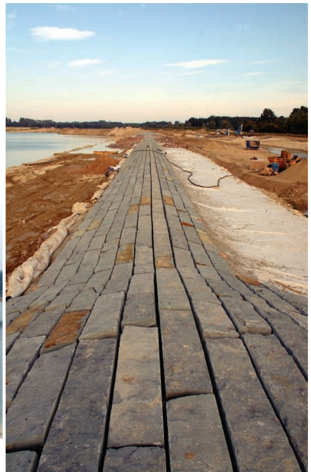
Hochwasserentlastungsdamm während der Vorschüttung und mit fast fertiger Abdeckung (rechts)
